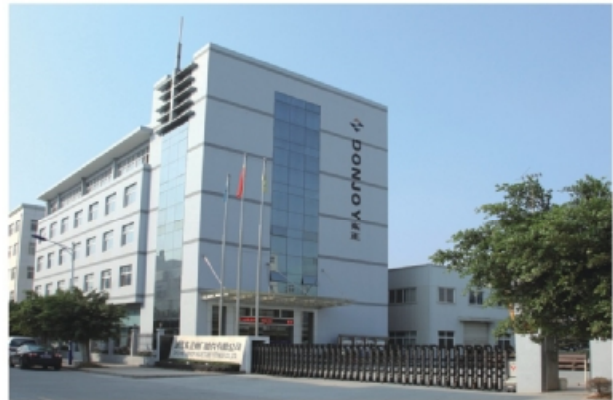
创立于2005年现代化工厂 温州滨海经济开发区生产基地 Wenzhou binhai economic development zone production base
